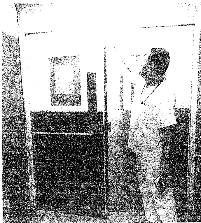
Ilustración 20. Pestillos de puertas vaivén del segundo piso no cierran correctamente, se bajan de posición. El sistema de portero eléctrico no funciona adecuadamente.
