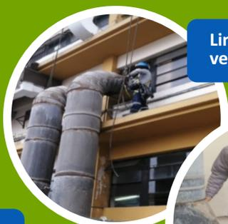
Limpieza de los ductos del sistema de extracción de secadoras de la Unidad de Lavandería
