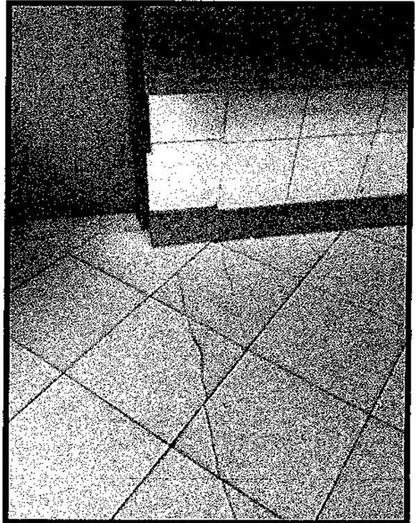
**FOTO N°33:** FISURAMIENTO EN PISO PRODUCTO DE FALTA JUNTA SÍSMICA; EMERGENCIA ADULTOS.
