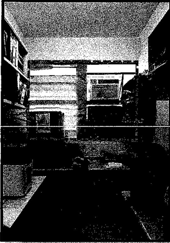
**FOTO N°90:** VENTANAS SIN VIDRIO (PAPEL), SE DETECTA INSTALACION DE EQUIPO DE AIRE ACONDICIONADO – LABORATORIO CENTRAL.
