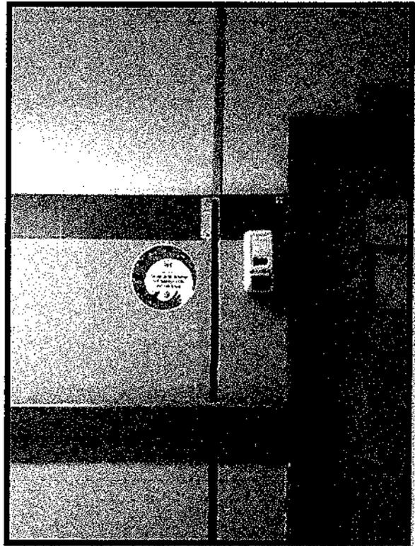
**FOTO N°14:** FALTA DE TAPA EN JUNTA SÍSMICA; MEDICINA A.
