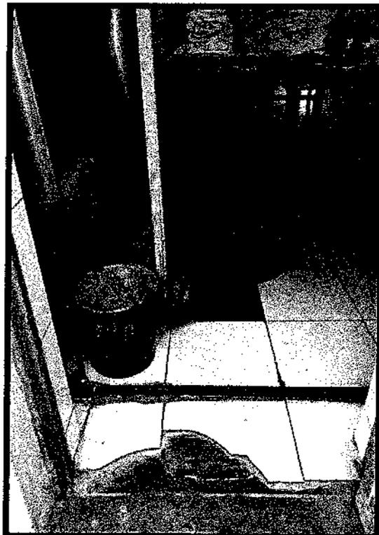
**FOTO N°121:** SE IDENTIFICÓ PISO CON DETERIORADO PARCIAL EN EL AMBIENTE DE SELECCIÓN DE ROPA DE LA UNIDAD DE LAVANDERÍA.
