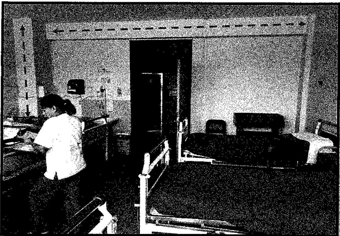
**FOTO N°19:** SISTEMA ESTRUCTURAL ENMARCADO (VIGAS Y COLUMNAS) EN AMBIENTE DE HOSPITALIZACIÓN.
