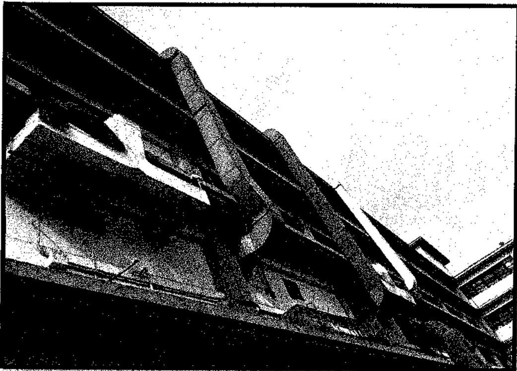
**FOTO N°167:** DUCTERÍA COLGANTE EN LAS PAREDES DE LOS BLOQUES DE HOSPITALIZACIÓN, LOS CUALES REQUIEREN DEL MANTENIMIENTO PREVENTIVO EN SUS EQUIPOS COMO EN SOPORTES YA QUE ESTOS TIENEN UNA ANTIGÜEDAD APROXIMADA DE 10 AÑOS.
