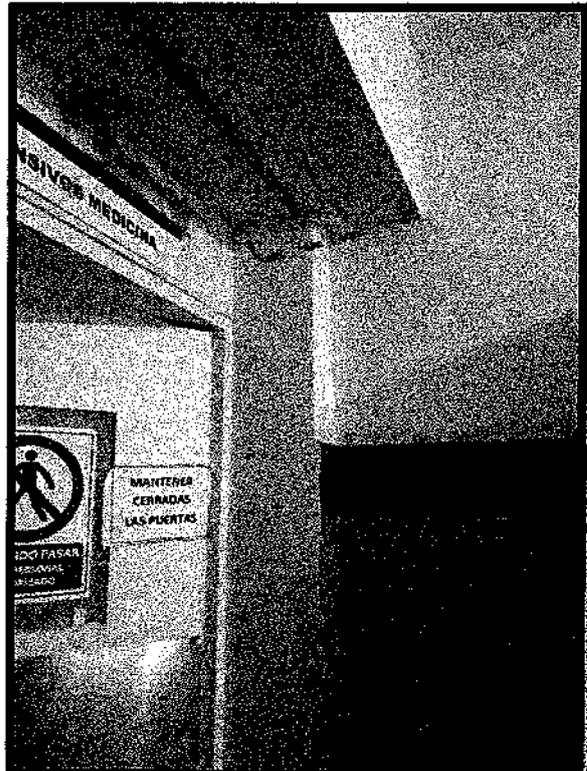
**FOTO N°16:** JUNTA SÍSMICA OBSTRUIDA; MEDICINA B Y EL BLOQUE DE TORRE UCI.
