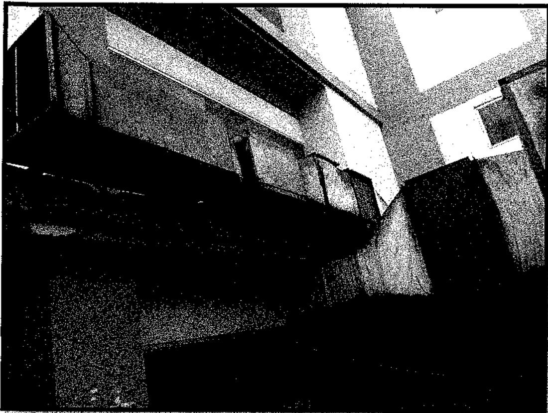
**FOTO N°163:** DUCTERIA DE EQUIPOS DE CLIMATIZACION Y SOPORTES ANCLADOS EN LA LOSA.
