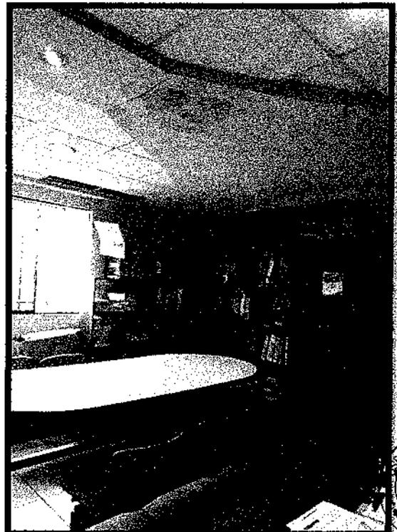
**FOTO N°108:** CIELO RASO DETERIORADO EN LA SALA DE REUNIONES DE LA OFICINA DE SERVICIOS GENERALES Y MANTENIMIENTO.
