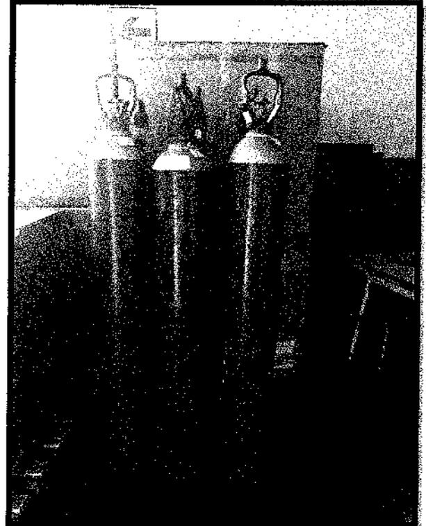
**FOTO N°153- N°154:** ALMACÉN IMPROVISADO DE LOS BALONES DE GASES MEDICINALES: SE PUEDE APRECIAR ACTUALMENTE SU UBICACIÓN ES EL ACCESO DE CIRCULACIÓN HACIA LOS AMBIENTES DE NUTRICIÓN, ALMACÉN Y LOGÍSTICA UBICADOS EN EL SÓTANO DEL BLOQUE DE HOSPITALIZACIÓN, PUES ESTA PRÁCTICA QUE SE VIENE REALIZANDO NO ES LO CORRECTO PORQUE NO CUENTA CON LOS NORMAS DE SEGURIDAD, ES POR ELLO QUE SE NECESITA UN LUGAR DESIGNADO E IMPLEMENTADO PARA SU CORRECTO
