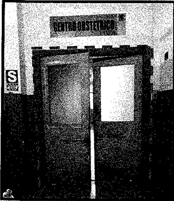
**FOTO N°55:** PUERTA DE ACCESO PRINCIPAL DE DOBLE HOJA, UBICADA EN EL TERCER NIVEL DEL BLOQUE DE HOSPITALIZACION, SE VISUALIZA DETERIORO EN LA INFERIOR Y LA CARENCIA DEL MANDIL PROTECTOR DE ACERO.
