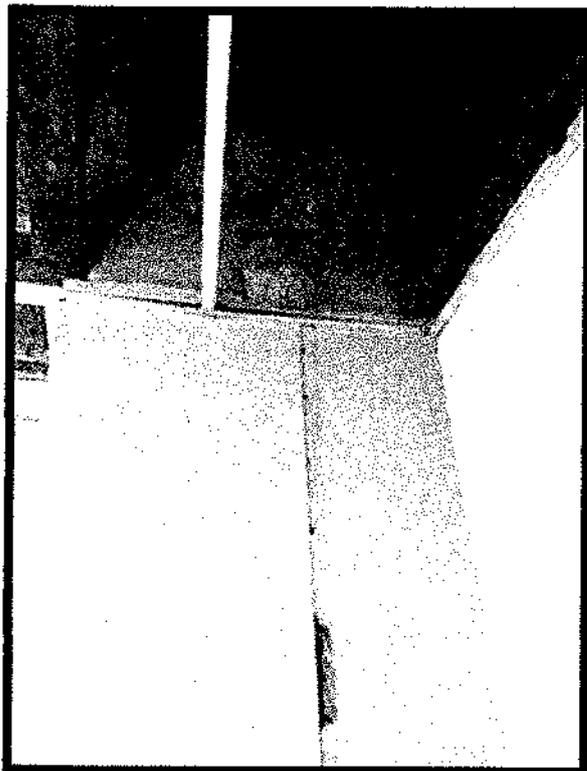
**FOTO N°30:** SE HAN SELLADO LA JUNTA SÍSMICA CON CONCRETO POBRE; SÓTANO.
