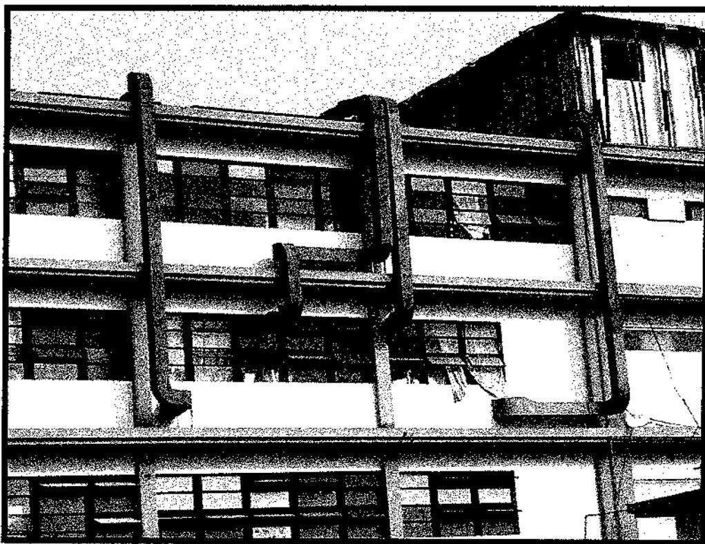
**FOTO N°160:** DUCTERÍA DE EQUIPOS DE EXTRACCIÓN EN EL BLOQUE DE HOSPITALIZACIÓN (CIRUGÍA B) EL CUAL SE ENCUENTRAN INOPERATIVOS POR FALTA DE MANTENIMIENTO
