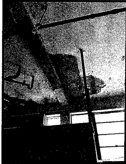
**FOTO N°02:** EFECTO DE TORSIÓN EN VIGAS PRINCIPALES PRODUCTO DE VIGAS SECUNDARIAS;
